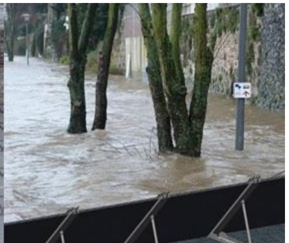
Skrå opstilling giver højere styrke
