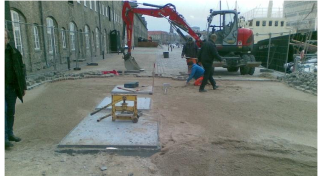
HydroSeparator® under etablering på Holmen, København
