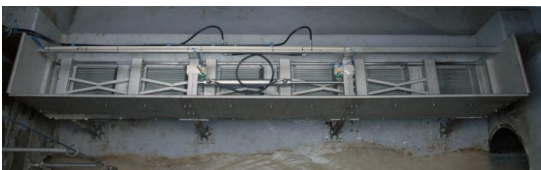
HydroScreen overløbsrist fjerner partikler > 4 mm
