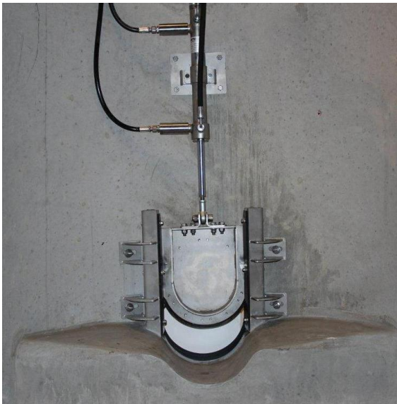
HydroSpjæld til skylning og regulering vha. hydraulik.
