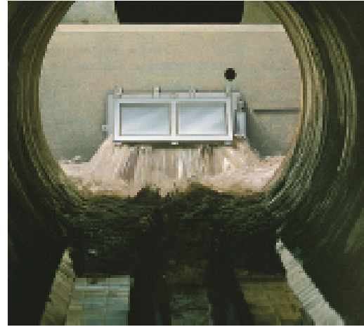
Skylning af rørbassin med HydroSelf skyllesystem
